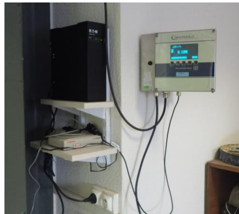
Electronique d'acquisition et de traitement du signal mesuré par la sonde - Modem pour la transmission des données
